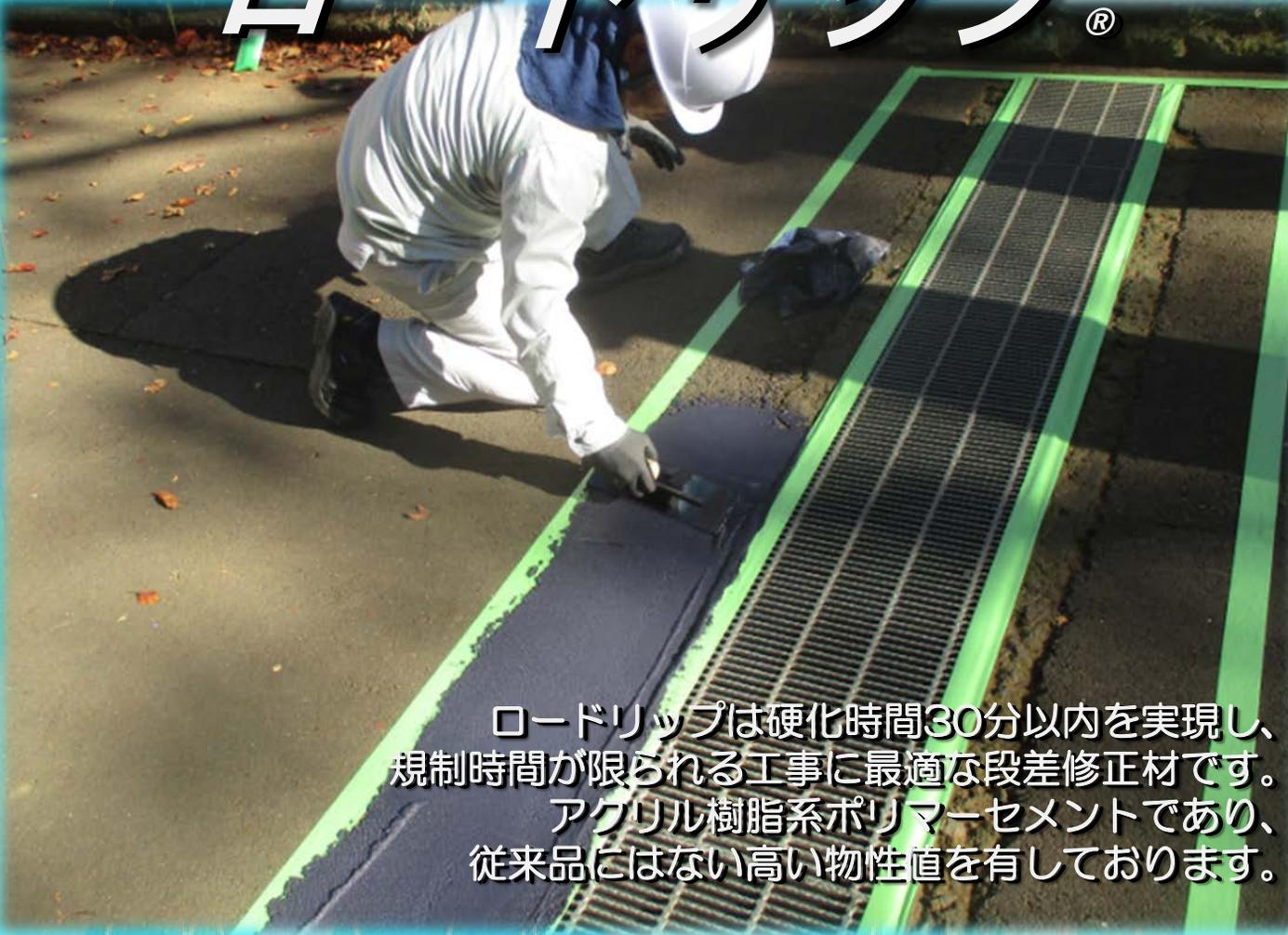
ロードリップは硬化時間30分以内を実現し、規制時間が限られる工事に最適な段差修正材です。アクリル樹脂系ポリマーセメントであり、従来品にはない高い物性値を有しております。
